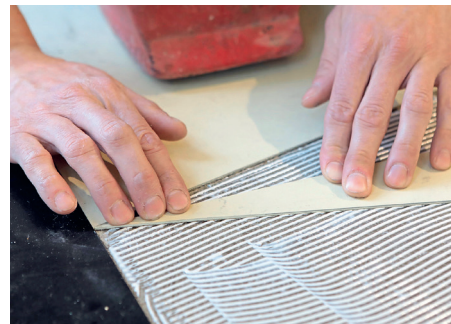
Bei der Lino-Verlegung à la Zimmermann liegen die Nähte dicht auf Stoß und werden nicht nachträglich verfugt.
