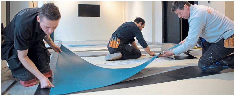
„Wir haben viele Jahre Erfahrung mit Lino. Ich liebe dieses Material“, sagt Mike Zimmermann, hier in der Mitte des Bildes beim Verlegen von Linoleum zu sehen.
